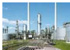
Contrôle de matériaux et inspection
