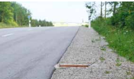
Un accotement de bonne largeur et de niveau avec la plateforme...
