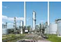
Contrôle de matériaux et inspection
